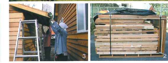
1.カナダ産のレッドシダーを使用した「シダーシエッド」は建物のヨコで収納だけでなくプラスアルファの趣味を実現する小屋。写真は、人気のタイプの「ランチャー」 2.こんなワンパッケージでお届け 3.屋根や床はパネル化されているので、2人1組いれれば約1日で完成
